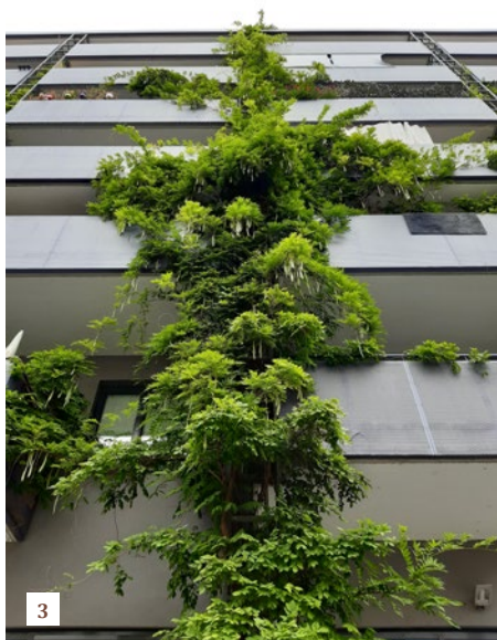
Popenjavka (plezalka) na fasadi. Fasada je svetlejših barv, da se manj segreva in s tem tudi manj ovira rastlino pri rasti.
